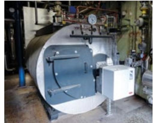
*Kombi-Dampfkessel zur Erzeugung von Heißdampf*
